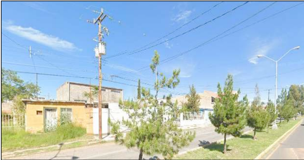
Imagen 77. Vista de redes eléctricas frente al predio de aplicación del plan.
