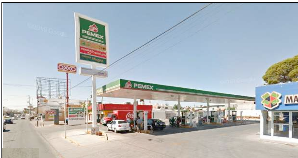
Imagen 85. Riesgo antropogénico, Gasolinera “Pemex”, en Av. Vallarta.
