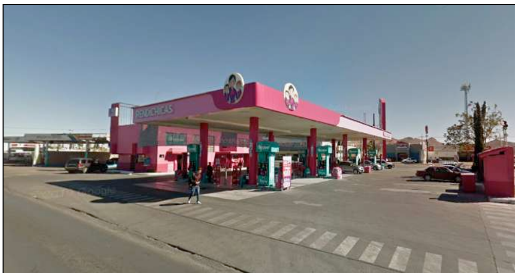
Imagen 60. Equipamiento de servicios. Gasolineras en polígono de estudio.
